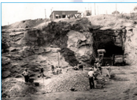
Construção do Túnel Canal que engloba os subsistemas Lameirão / Macacos que, com 45 km leva água da ETA para abastecer o RJ. Construído nos anos 1960, pela CEDAG
