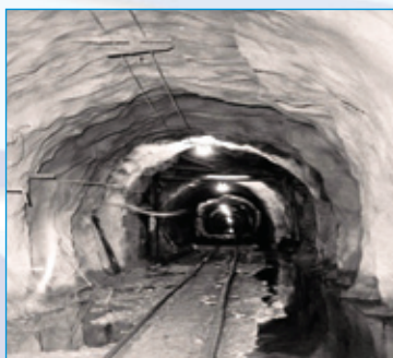
Construção do Túnel Canal que engloba os subsistemas Lameirão / Macacos que, com 45 km leva água da ETA para abastecer o RJ. Construído nos anos 1960, pela CEDAG
