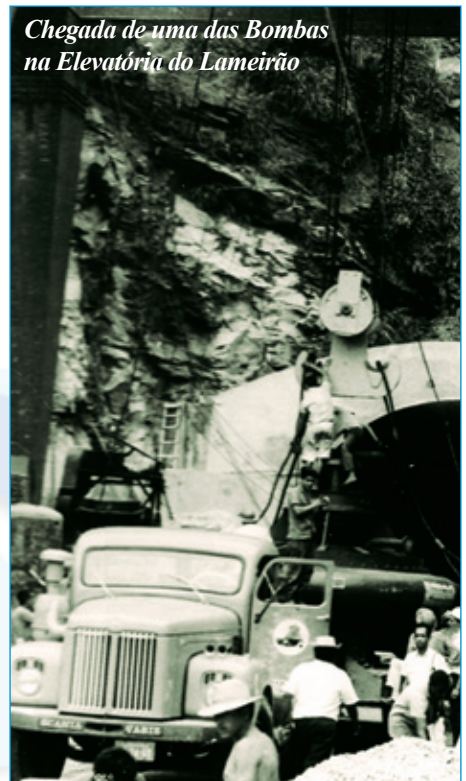
Construção do Túnel Canal que engloba os subsistemas Lameirão / Macacos que, com 45 km leva água da ETA para abastecer o RJ. Construído nos anos 1960, pela CEDAG
