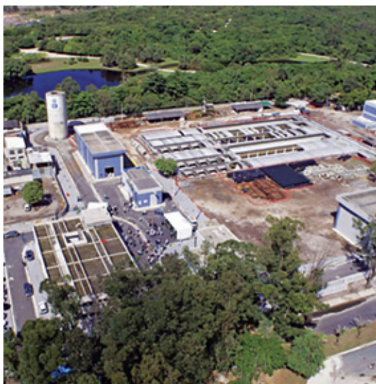
ETE da Barra da Tijuca (vista aérea)
