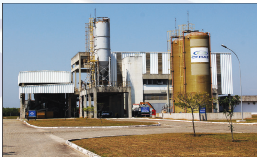
Estação de Tratamento de Esgotos de Sarapuí – Belfor Roxo
