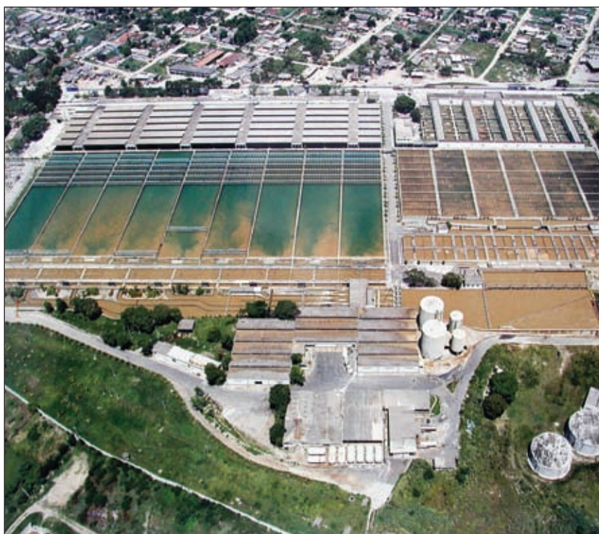
Vista aérea da Estação de Tratamento de Água do Guandú, a maior do mundo
