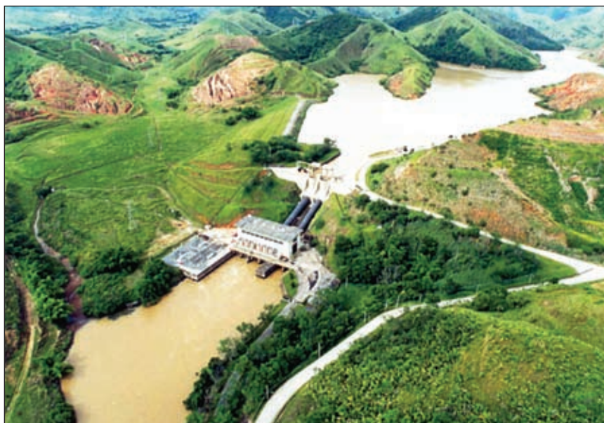
Vista aérea do lago e da Usina Hidrelétrica de Pereira Passos
