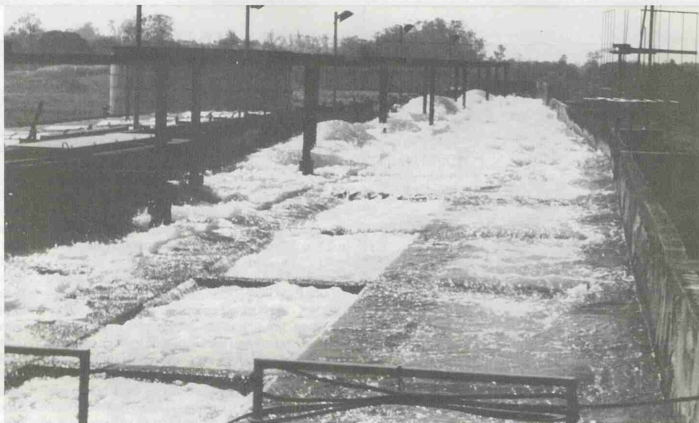
A Estação já opera com 43 mil litros por segundo, mas já está em condições de produzir até 47 mil litros/seg.
