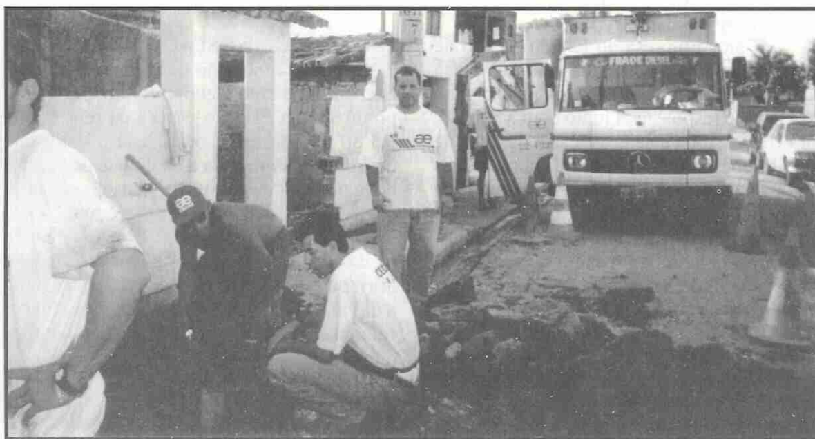
Empregados da Surzo trabalham no Mutirão de Sepetiba/Praia da Brisa, na Zona Oeste
